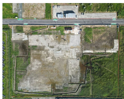
発電所建設地空撮（2022年9月撮影）
