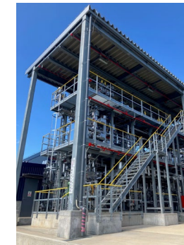
つばめBHB(株)製 低温・低圧オンサイト型アンモニア合成設備
