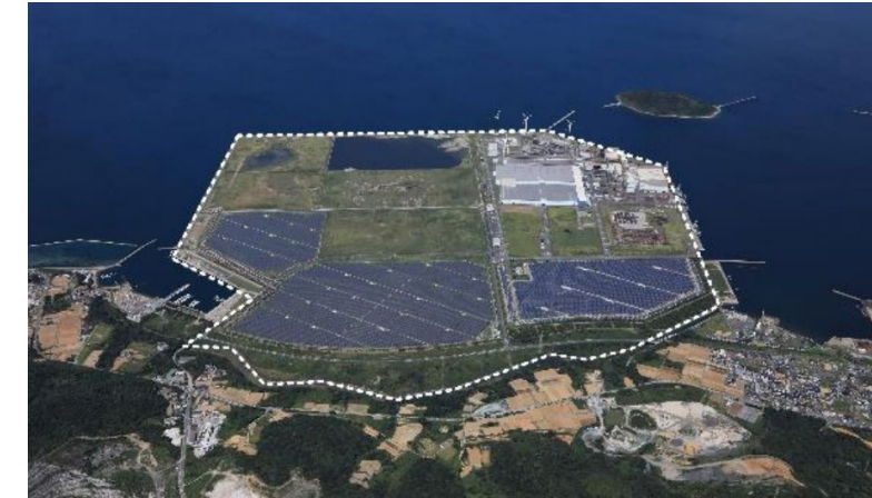
田原バイオマス発電所建設予定地（愛知県田原市）
