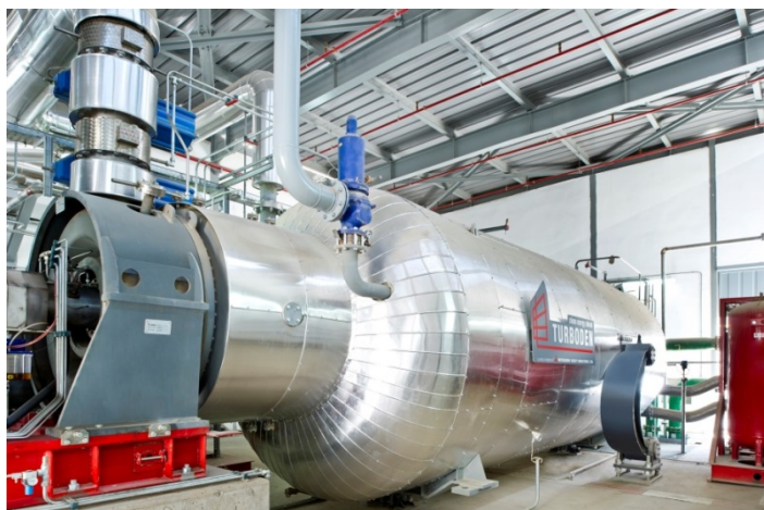
大型バイナリー発電装置(ターボデン社製)
